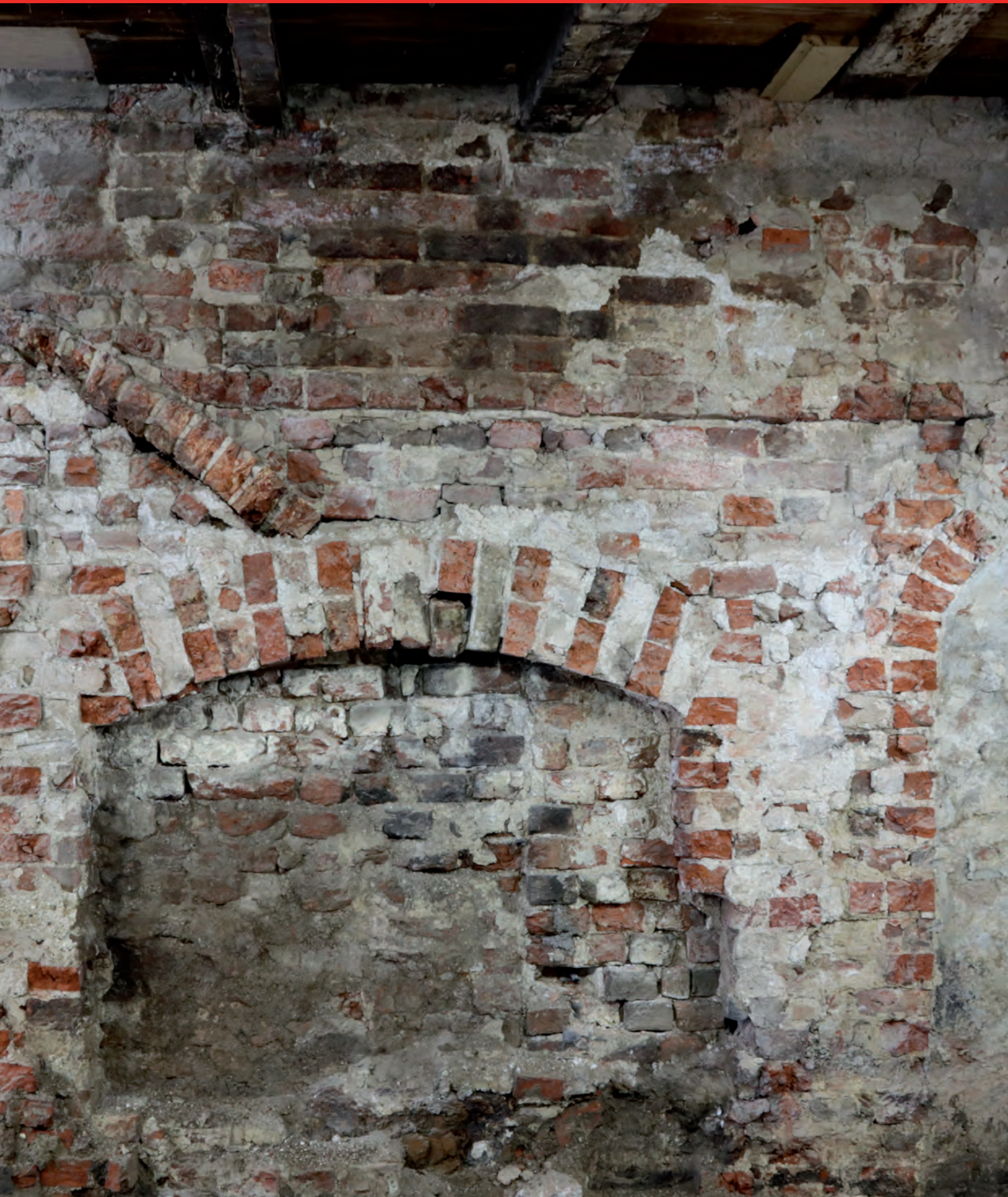
Abb. 28 Diverse Umbau- und Ergänzungsmaßnahmen in den Mauerwerken des Hauses Marlesgrube 67 zeugen von der bewegten Geschichte des Ortes.
