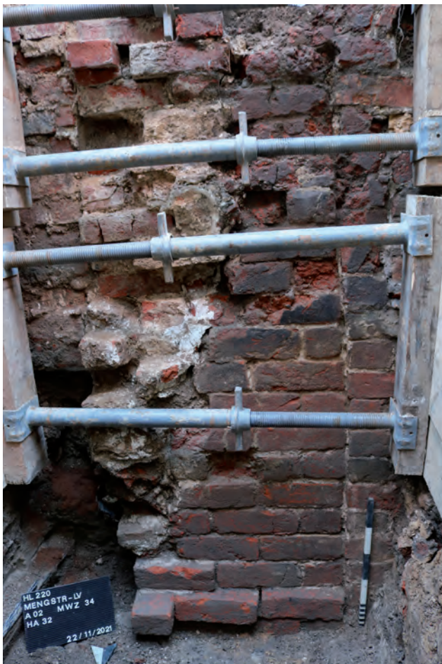
Abb. 42 Unten links: westliche Leibung eines ehemals ebenerdigen Eingangs in die Mengstraße 21, etwa 2,70 m unterhalb des heutigen Bürgersteigs. Von oben durch späteren Ausbruch für die Treppenwanne eines Kellerabgangs gestört. Rechts: Baufuge zur Mengstraße 23.
