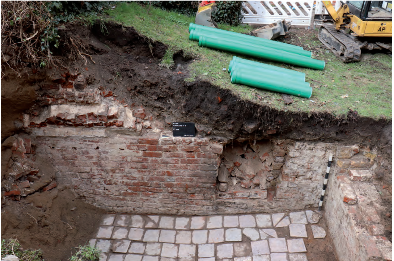
Abb. 5 Direkt unter der Grasnarbe des heutigen Innenhofes kamen die Mauer- und Gewölbereste von Alfstraße 12 des späten 13. und frühen 14. Jahrhunderts zu tage.
