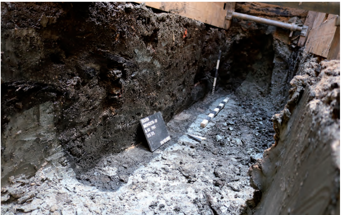
Abb. 34 Große Sickergrube unterhalb des Abzuggrabens, Straßenmitte vor Mengstraße 25. Solche Sickergruben wurden vermutlich aufgrund des geringen Gefälles in diesem Bereich eingebracht.
