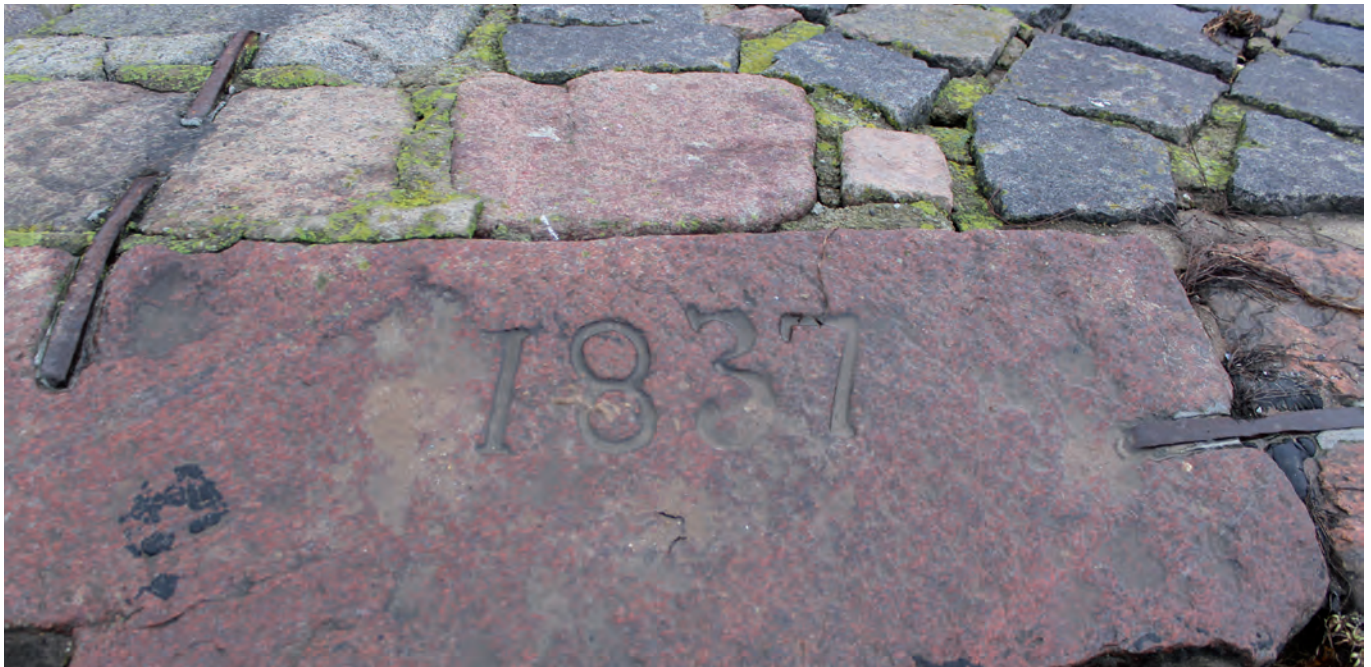
Abb. 41 Mit Eisenklammern verbundene Feldsteinquader. Hier mit der Jahreszahl 1837, dem Jahr der letzten großen Neubau- maßnahme an der Nordermole, versehen.
