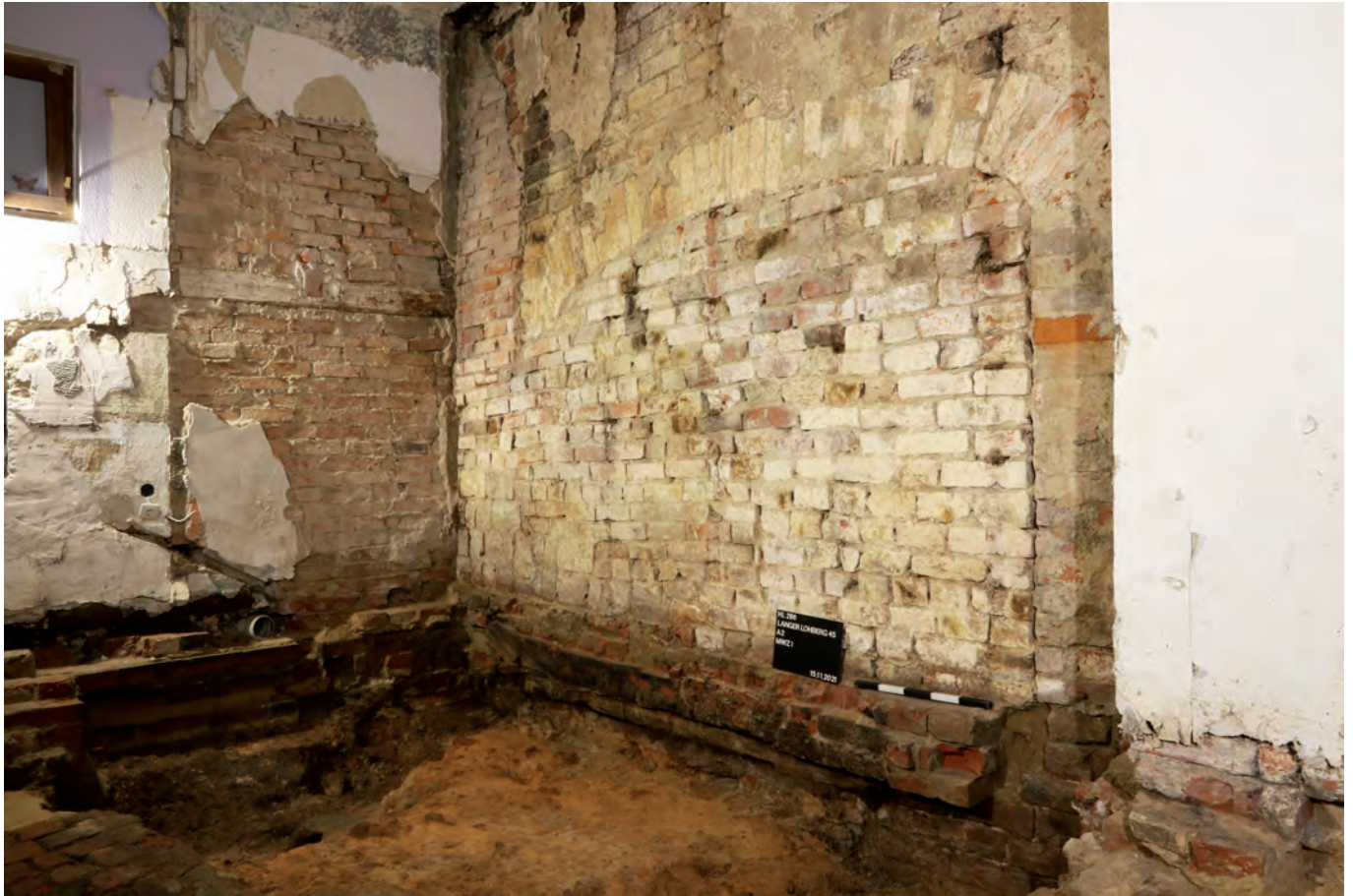
Abb. 27 Gut zu erkennen ist die Nischenöffnung über der Darre, die eine Vorstellung über die Gesamtgröße der technischen Anlage erahnen lässt.
