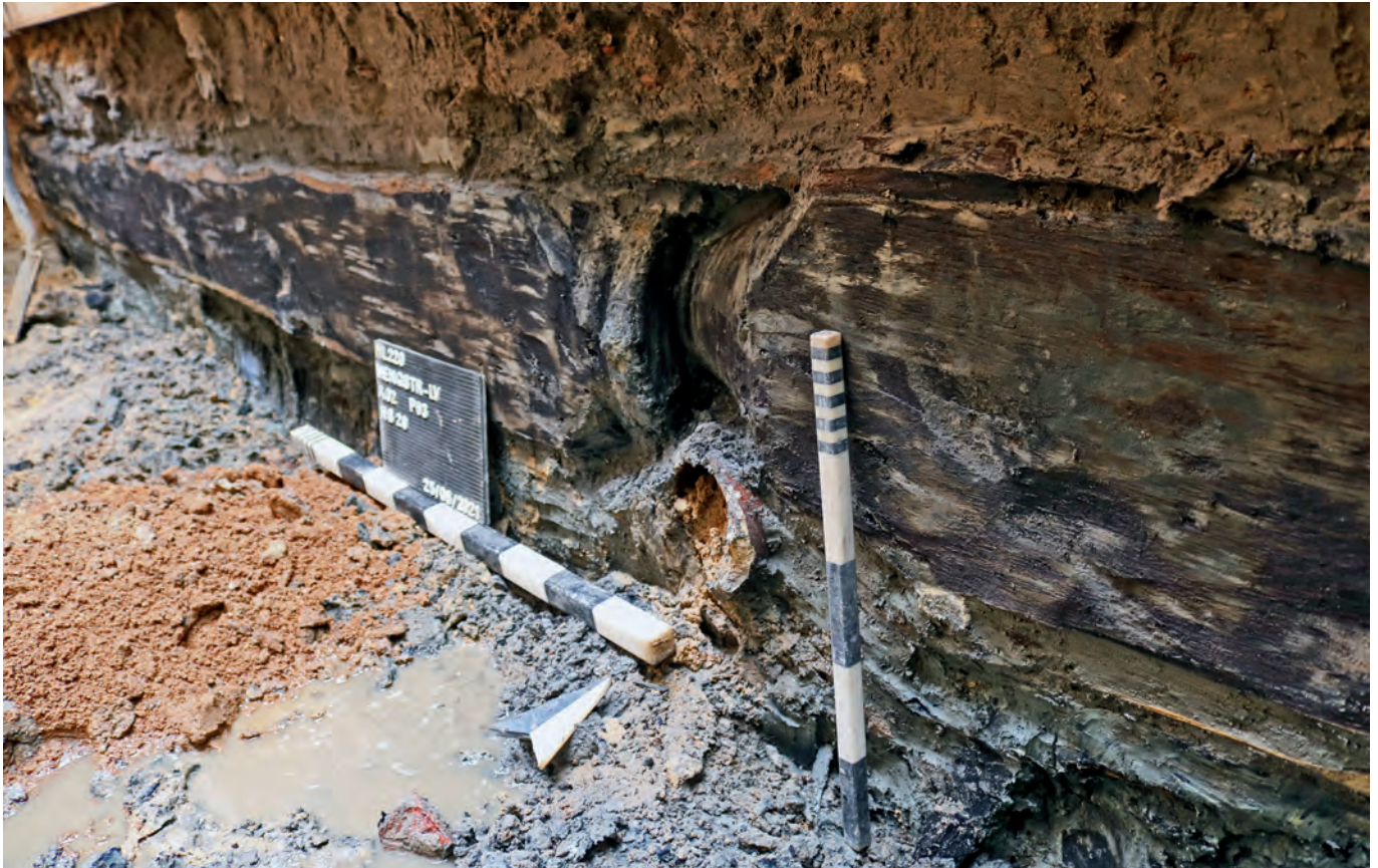
Abb. 40 Leitungsteile der Bürger- und Kaufleutewasserkunst von 1532, Verbindungsstelle mit Eisenmuffe zwischen den der Länge nach durchbohrten Holzbalken. Die Leitung liegt etwa 3,40 m unter der heutigen Straßenoberfläche.
