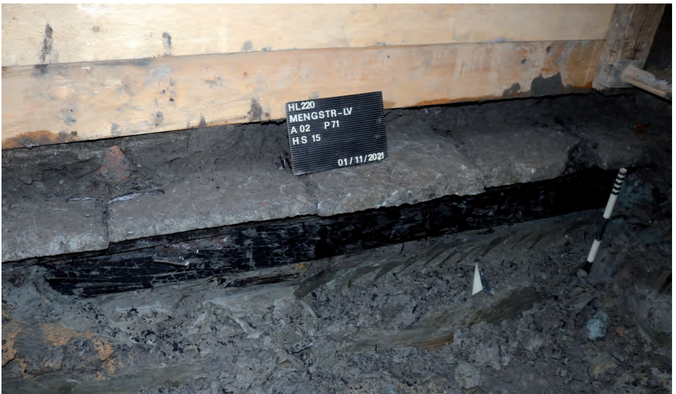
Abb. 41 Holz-Drainageleitung im Kreuzungsbereich Meng-/Blocksquerstraße, etwa 3,40 m unterhalb der heutigen Straßenoberfläche. In diesem Bereich zusätzlich mit aufgelegten Kalksteinplatten geschützt.
