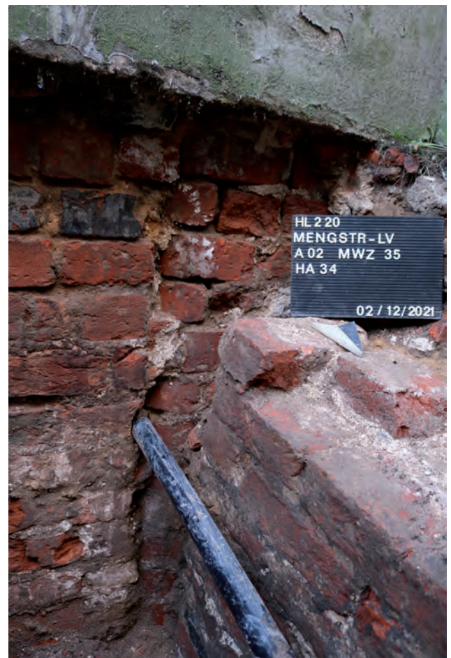
Abb. 43 Westliche Leibung eines ehemaligen Eingangs in die Mengstraße 19, Mauerecke mit Viertelstab-Formsteinen ausgeführt. Die von Norden gegengesetzte Treppenwanne dokumentiert den späteren Umbau zum Kellerabgang.
